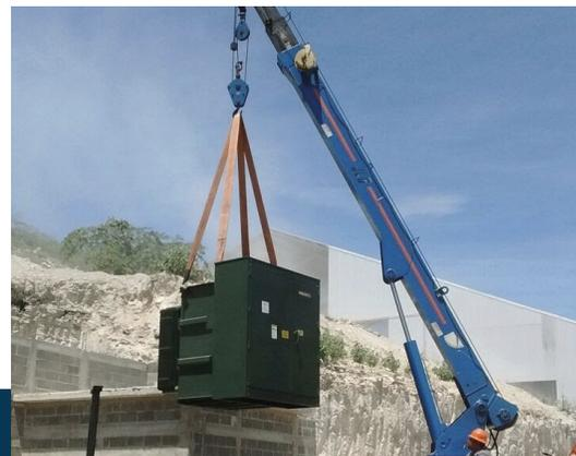
Cambio de transformador para poder recibir la generación de una planta solar de mayor potencia.
