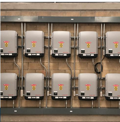
Arreglo de inversores Fronius con método de tablero de pruebas de cadenas DC de fácil acceso.
